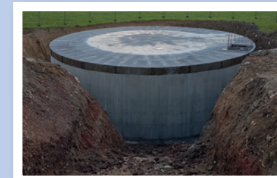
Eisspeicher-Betonbehälter
