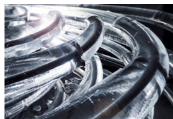
Eisschicht am Wärmeübertrager
