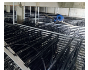
Montage Wärmeübertrager
